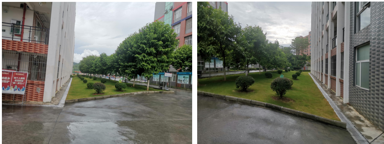
建构筑物周边盖板排水沟及景观绿化
