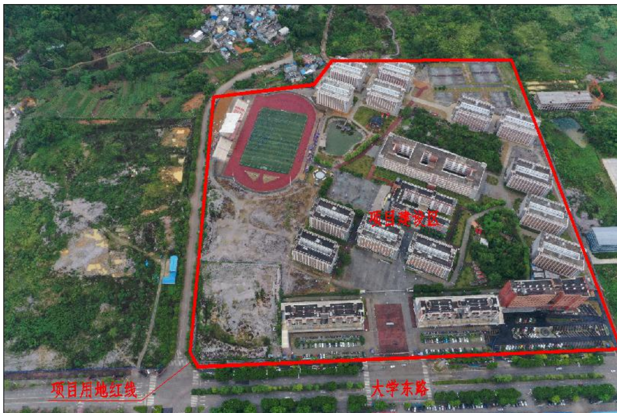
项目区航拍图
